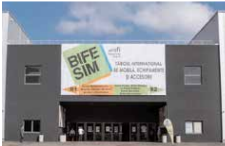
AFISARE BANNER PE FATADA PAVILIONULUI B3
